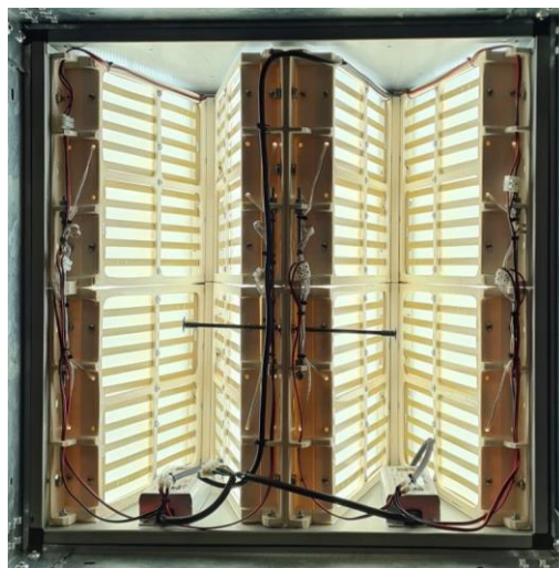
Filtro T BIO-AIR in funzione
