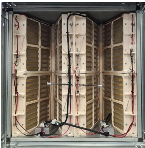
Controtelaio portafiltro con molle di bloccaggio per prefiltro G4 ondulato
